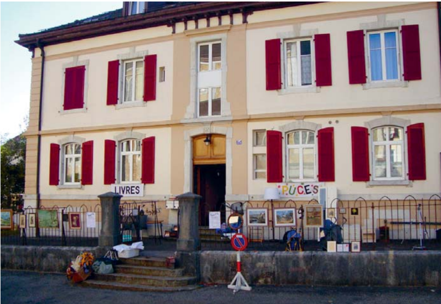
Hier entsteht das Centre Paroissial der Église Réformée Évangélique La Chaux-de-Fonds
